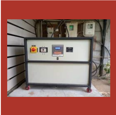
160kva Linear Servo Voltage Stabilizer
