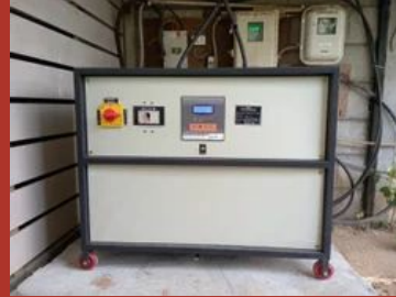
630kva Linear Servo Voltage Stabilizer
